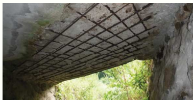
床版の鉄筋が露出する橋梁
