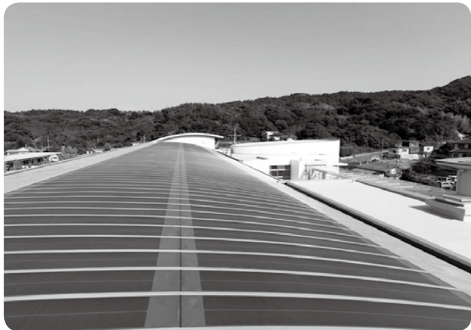
▲太陽光パネル
