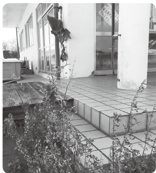
▲切串シーサイドハウス (未使用施設の現況)
