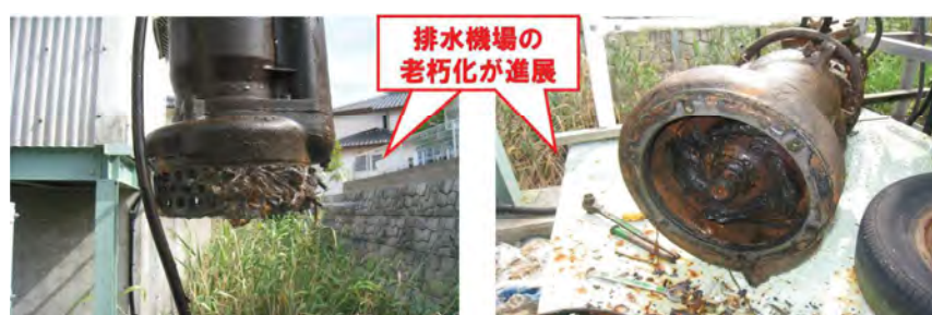
図 2.5 ポンプ場施設の老朽化状況
