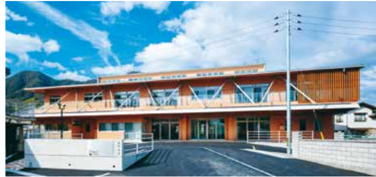
切串交流プラザ（1階）／認定こども園きりくし（2階）
