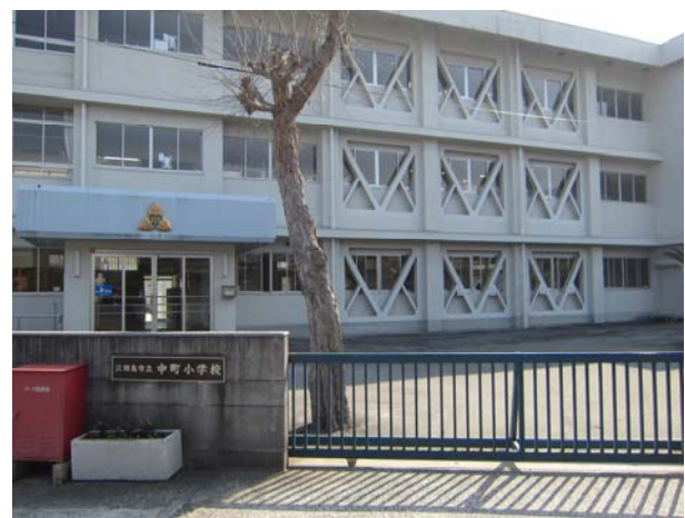
中町小学校（昭和52（1977）年度建設）
