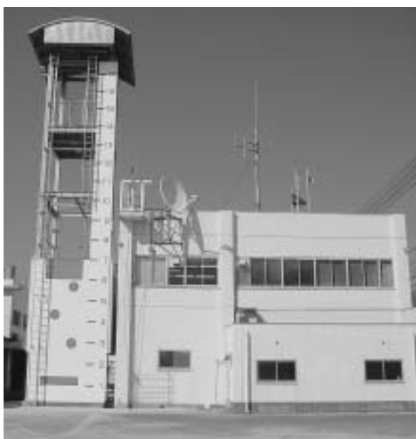
消防訓練塔(3月7日消防記念日に完成) 高さは19.7mでビル6階建ての高さに相当
