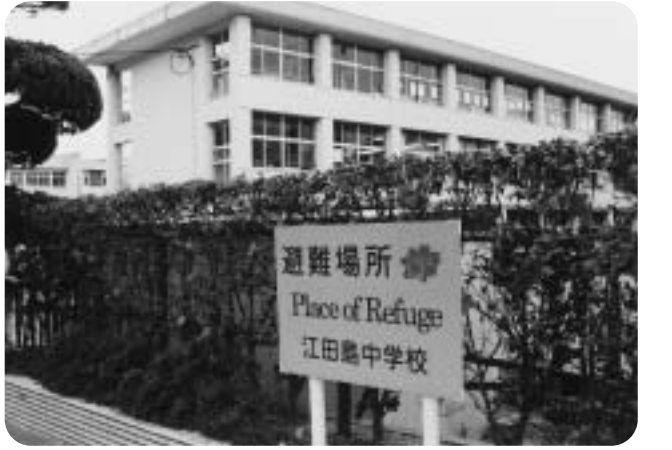
↑急がれる安全対策
