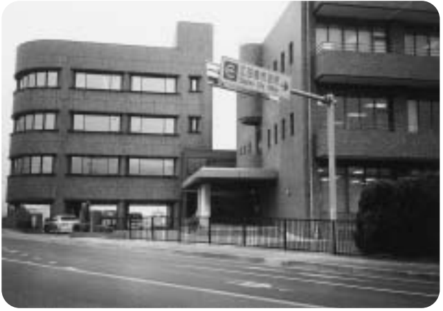
↑仮本庁舎(旧能美町役場)
