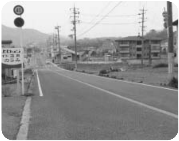
▲歩道の設置が望まれる国道487号
