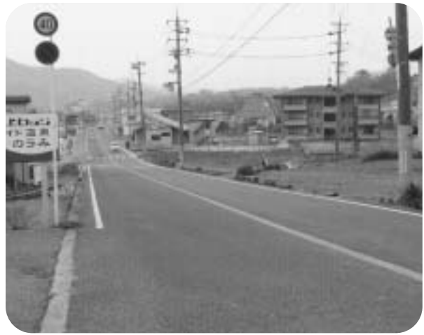
▲歩道の設置が望まれる国道487号
