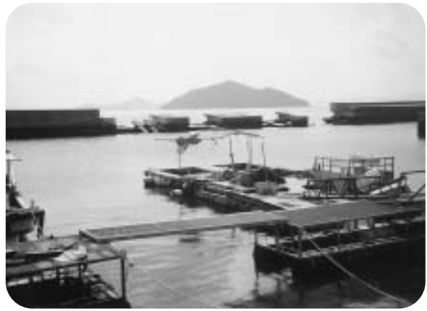
▲ 台風18号で被害を受けた外美能漁港
