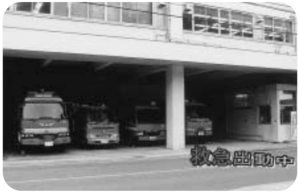
▲江田島市消防本部
