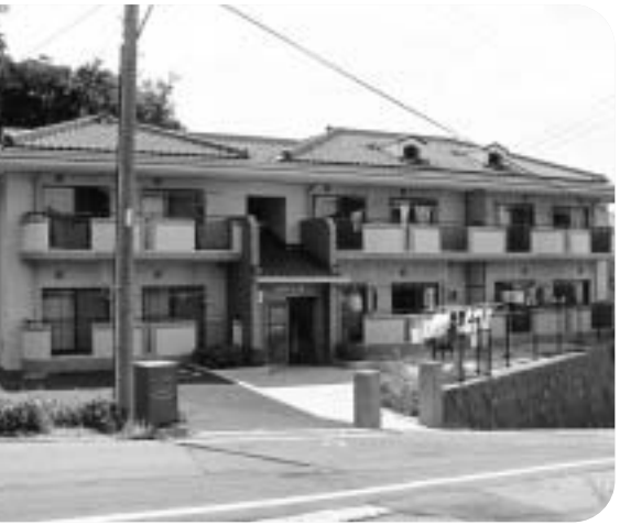
▶改築された美能公営住宅(沖美町美能)
