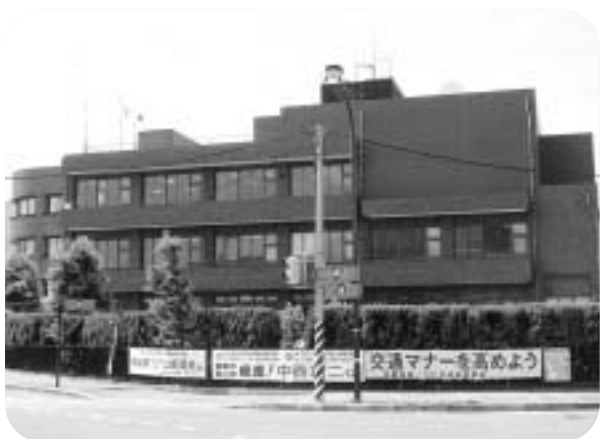
▲多くの職員が勤務する新市の仮本庁舎
