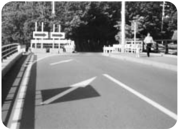
▲道路拡張が望まれる大柿町沖野島橋付近
