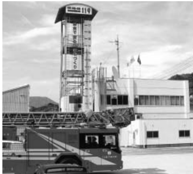
指令センターI型を設置する市消防本部
