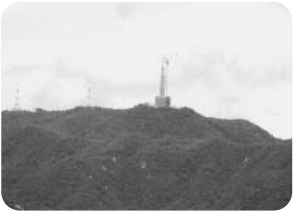
▲建設が進む中継局アンテナ (広島市：絵下山)
