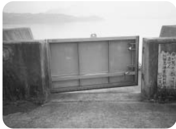
▲防潮扉が設置された江田島町矢ノ浦地区
