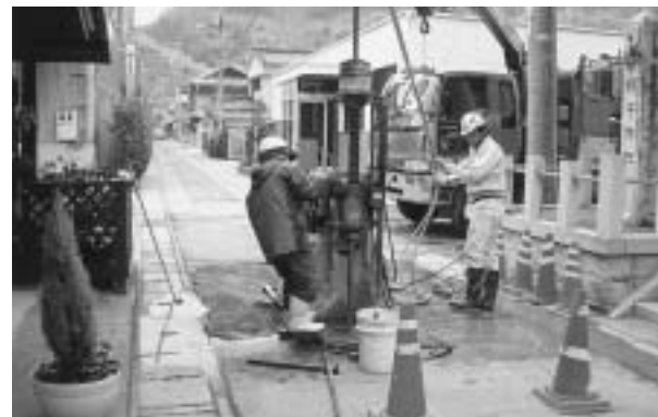
▲下水道管築造のためのボーリング調査（大柿町大原）
