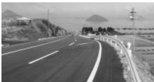
▲供用開始した県道石風呂切串線（江田島町切串）
