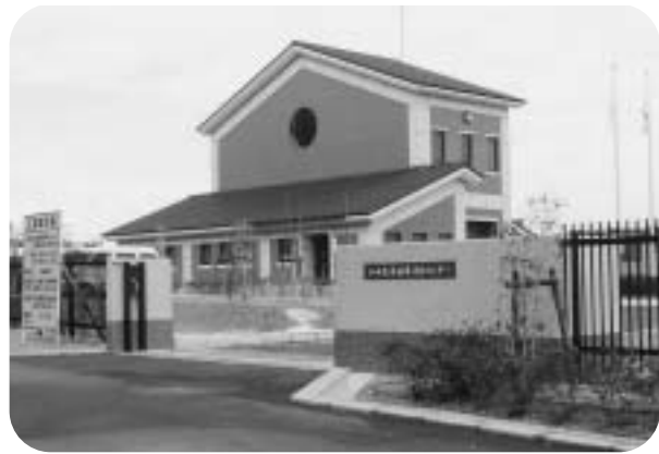
▲整備が進む下水処理場（切串浄化センター）
