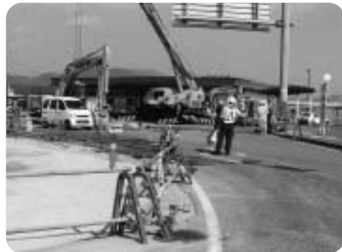
▲ 改修工事が進む小用港
