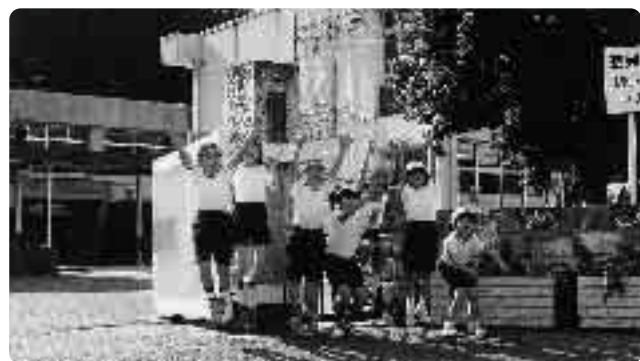
▲小用小学校（江田島中学校建設予定地）
