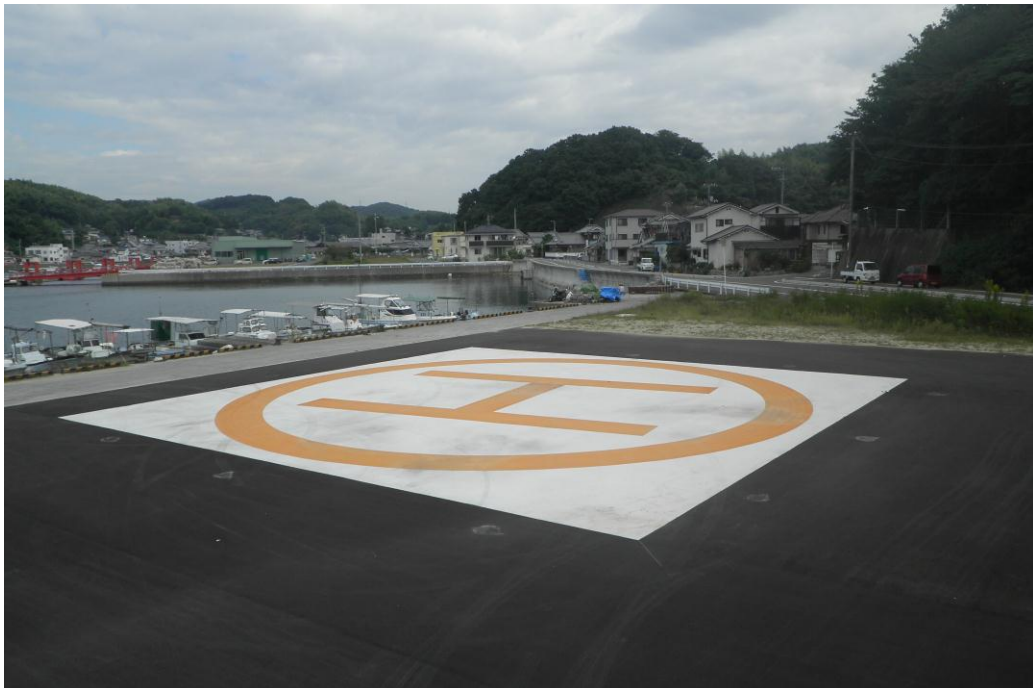
簡易ヘリポートの設置状況（写真は深江漁港）
