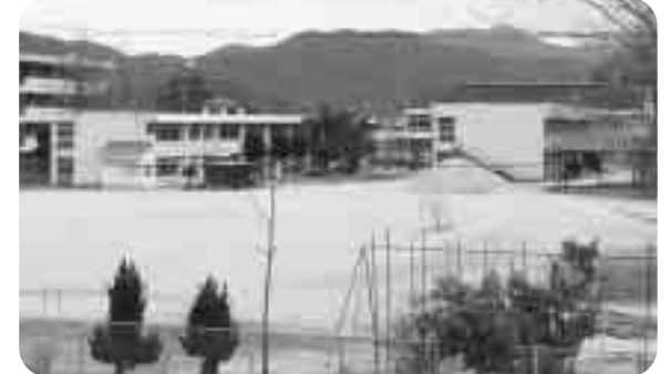
▲江田島中学校建設場所(旧小用小学校)
