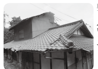
▲今にも倒れそうな空き家
