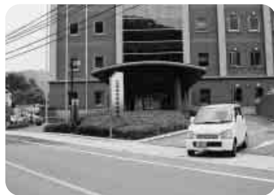
▲ 市福祉事務所・教育委員会が利用している旧県大柿合同庁舎
