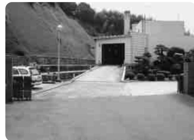
▲ 昭和50年に建設された浄化センター
