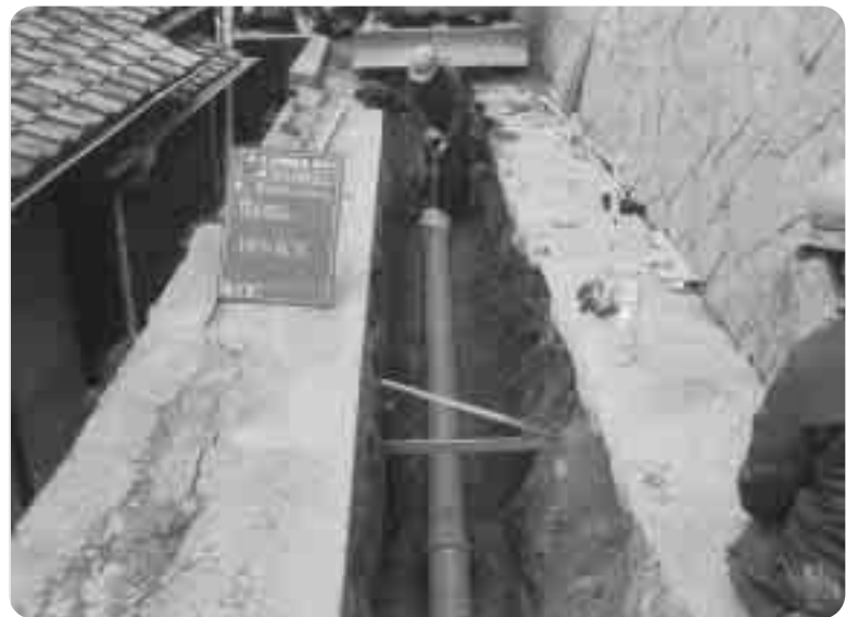
▲ 整備が進む下水道工事
