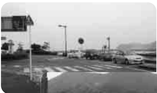
▶ 駐車場が不足している切串西沖棧橋
