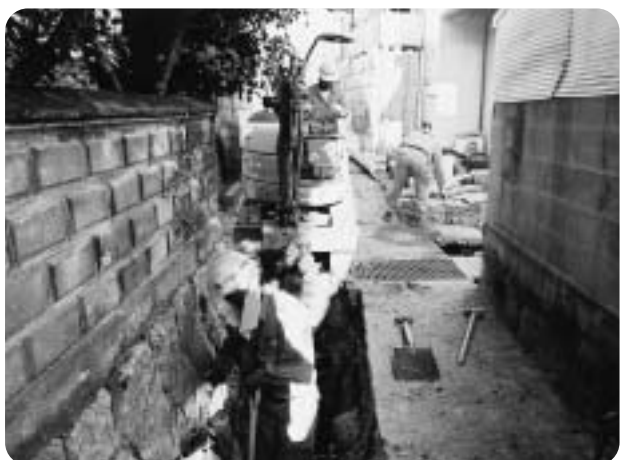
▲ 整備が進む下水道工事
