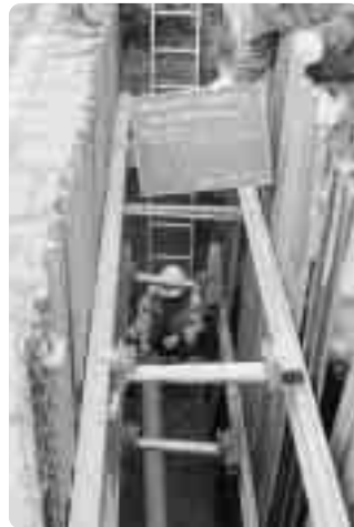
▲ 公共下水道管布設工事
