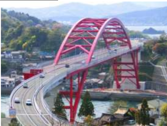
警固屋音戸バイパス（第2音戸大橋）
