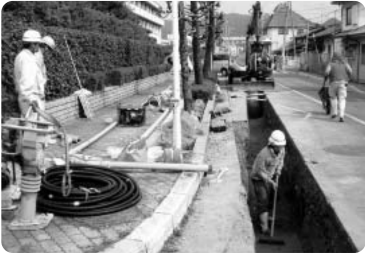
▲ 下水道配管工事（江田島町切串）
