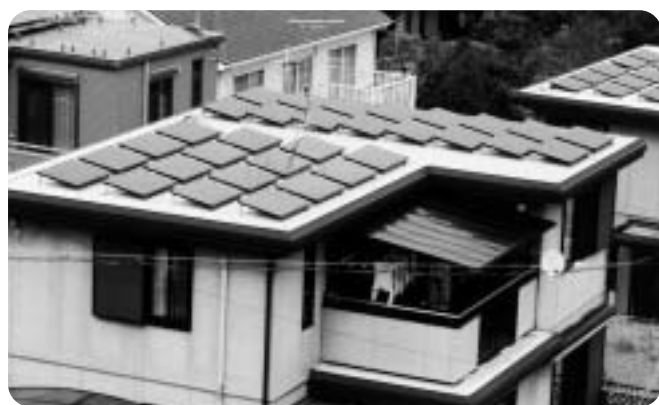
▲ 住宅用太陽光発電システム（江田島町津久茂）
