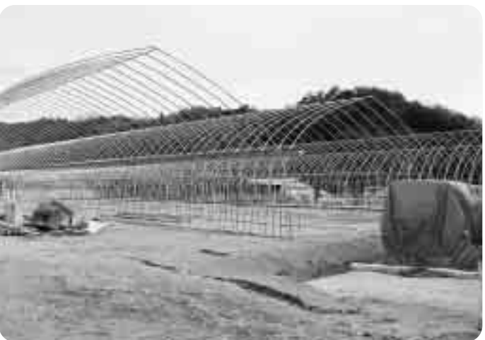
▲ 建設中のサイトピアハウス（沖美町）
