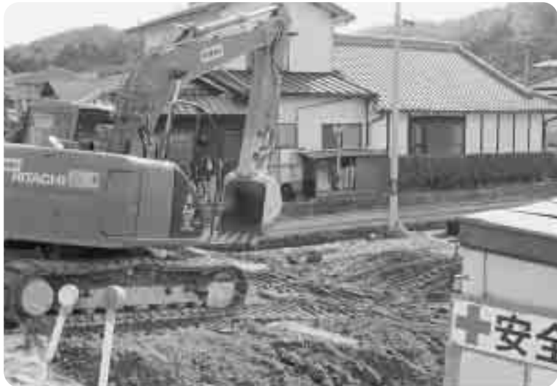
▲ 道路工事中 (大柿町)
