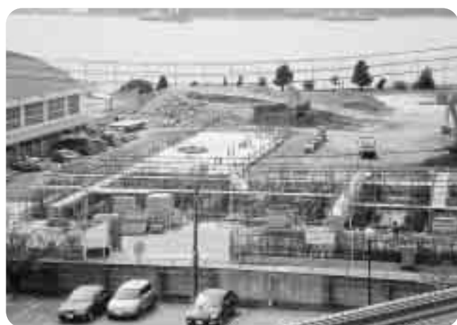
▲ 建設中の江田島小学校
