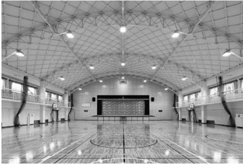
▲改修した江田島小学校屋内運動場
