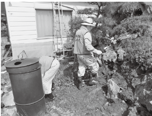
▲復旧作業の様子
