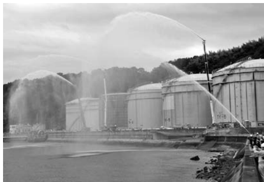
▶一斉放水の様子
