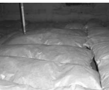
写真は床下の敷き炭。布袋やかごに入れ、室内の除湿にも使えます。お気軽にご相談ください。
