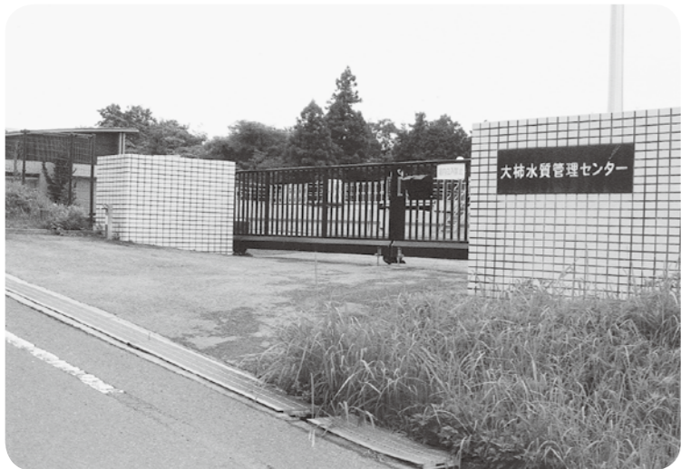
▲大柿浄化センター
