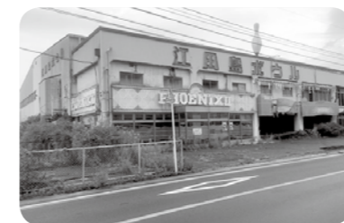
▲消防本部庁舎建設予定地
