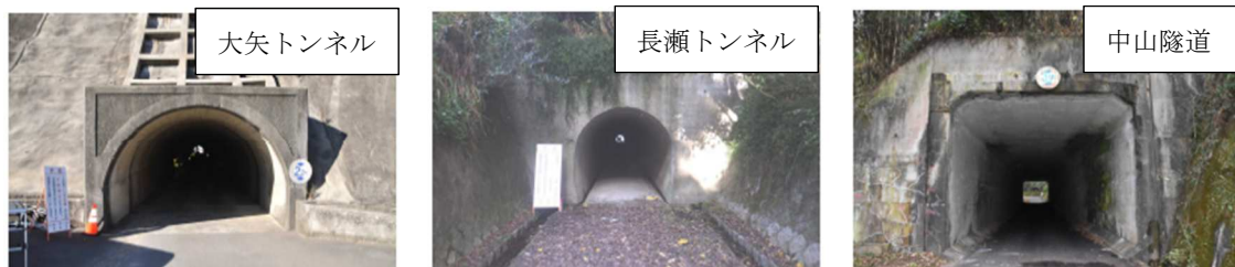
図 1-2 江田島市が管理するトンネル
