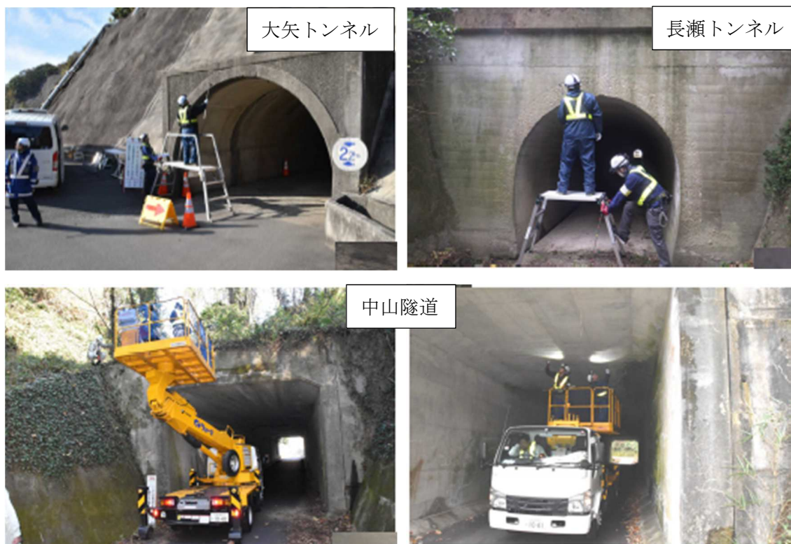
図1-3 トンネル定期点検状況（令和2年度）
