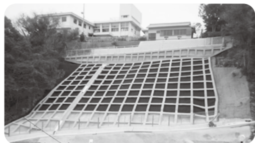
▲下野川地区のり面復旧工事
