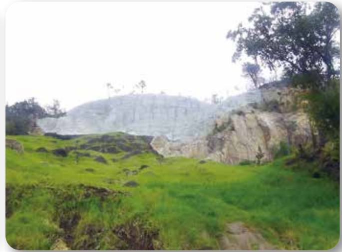
▲宮ノ原～幸ノ浦線災害復旧現場（江田島町大須）
