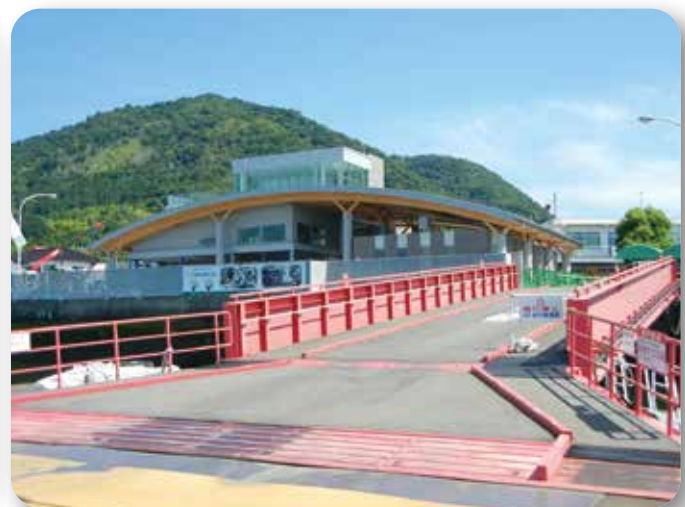
▲完成した三高港ゲートハウス（沖美町）
