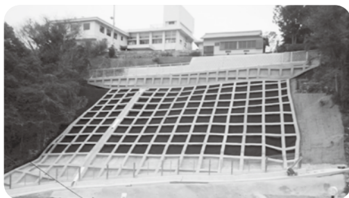
▲下野川地区のり面復旧工事
