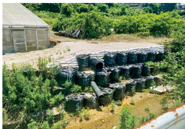
工事が完了していない箇所
