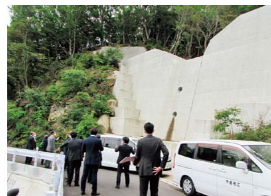
工事完了箇所
