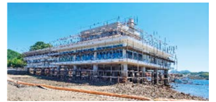
解体の進む旧能美海上ロッジ
