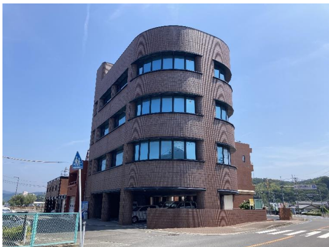
① 能美市民センター別館全景
