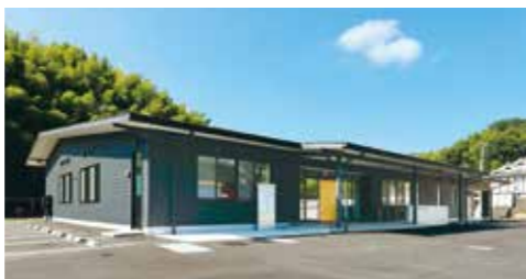
完成した飛渡瀬交流プラザ
